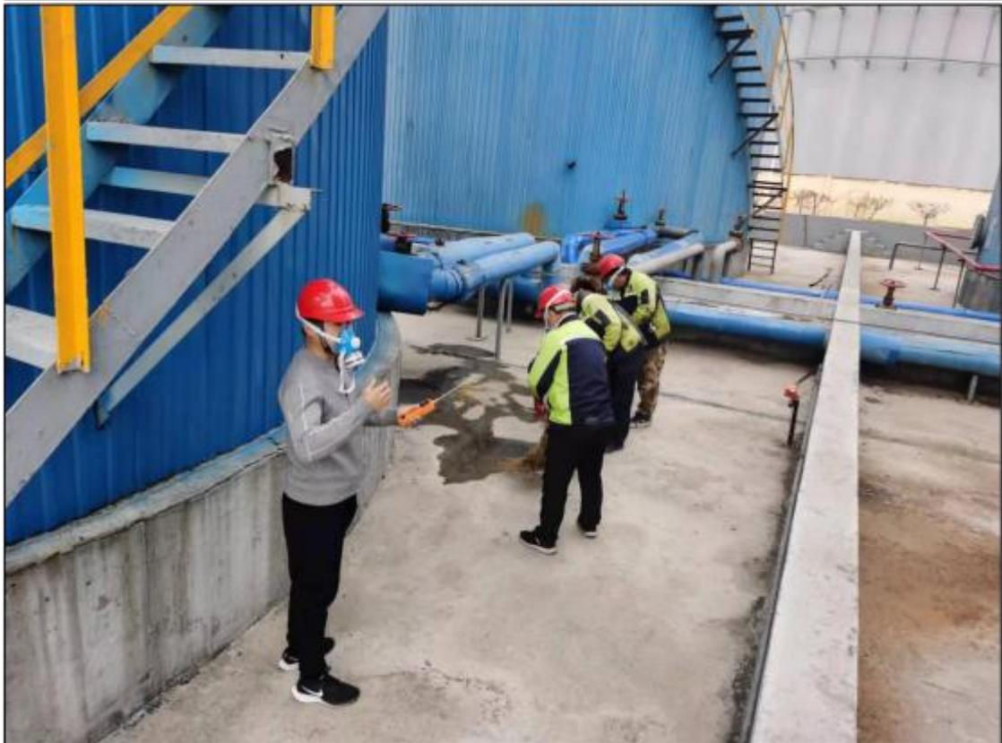
抢修完成，漏点已修复，应急处置小组把防止泄漏物料着火放在第一位，先使用沙土、白灰等围堵后回收清理对泄露的物料进行回收，确保物料不外流造成污染。
