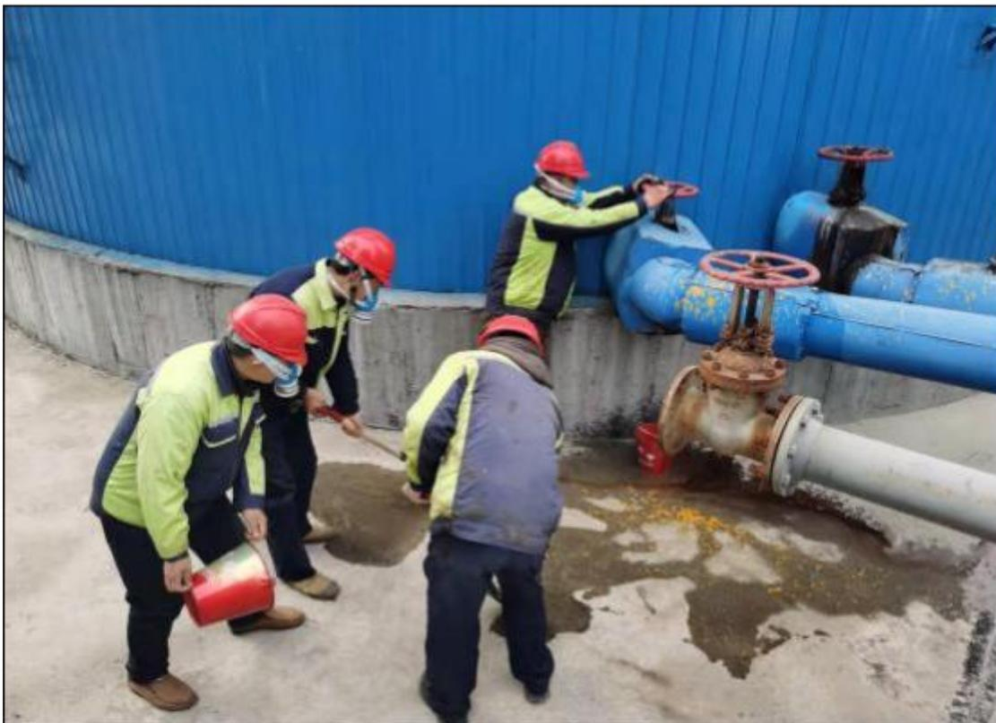
7、抢修完成，漏点已修复，应急处置小组把防止泄漏物料着火放在第一位，先使用沙土、白灰等围堵后回收清理对泄露的物料进行回收，确保物料不外流造成污染。
